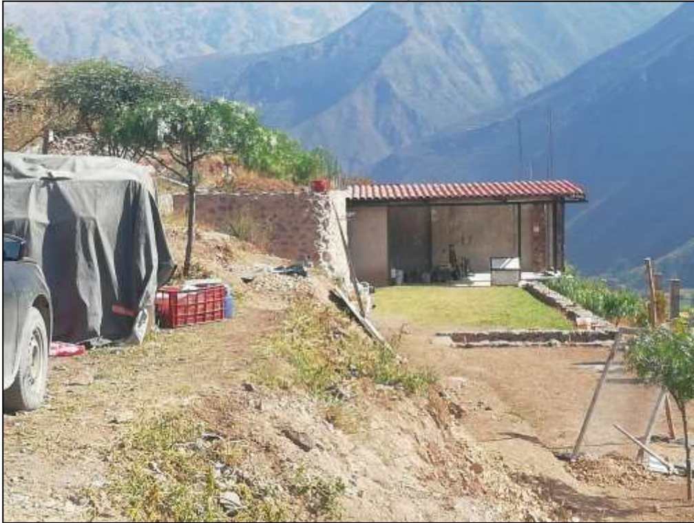
Foto N° 8. Edificación en proceso en el sitio arqueológico.
