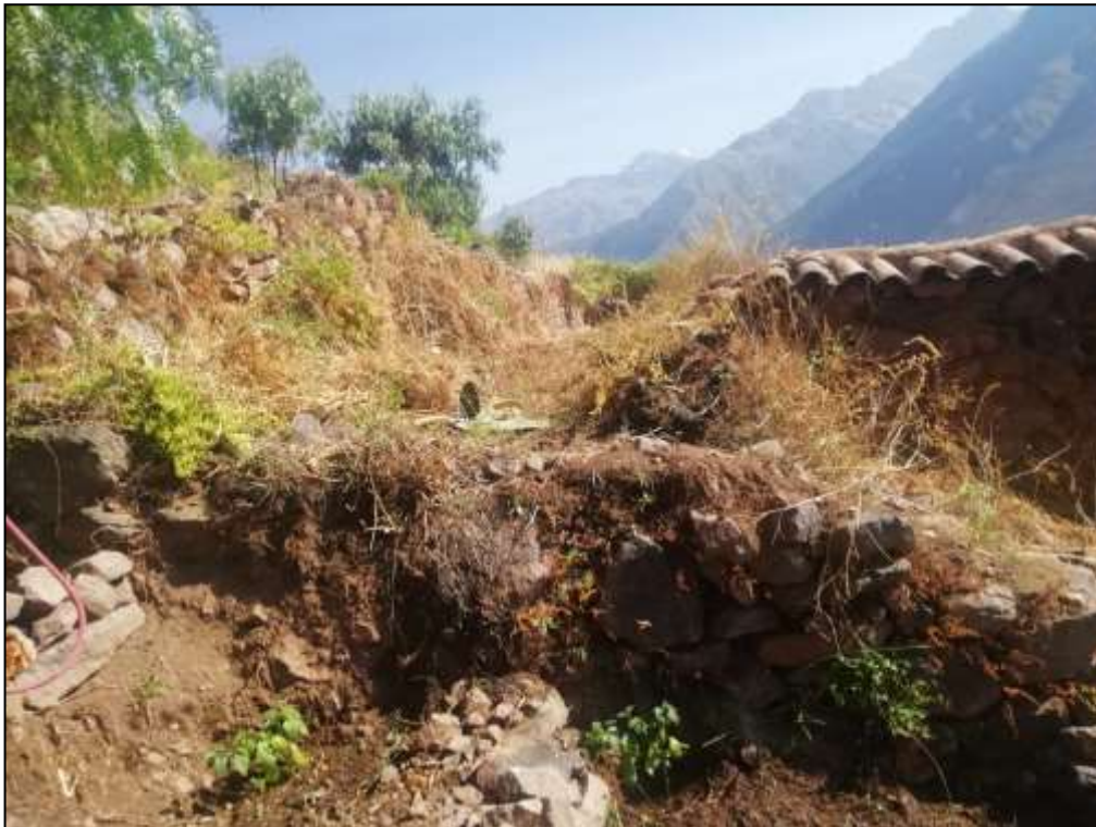
Foto N° 9. Vista de la afectación que se está realizando a una estructura prehispánica tratando de nivelar el terreno con fines agrícolas.
