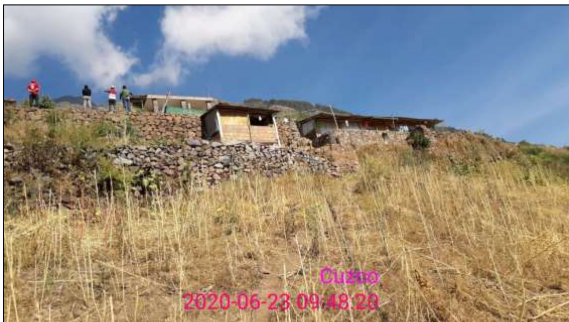
Foto N° 4 Vista de las construcciones realizadas en las plataformas de andenes, nótese que los muros han sido desarmados y vueltos a armar con el mismo material y con nuevo.
