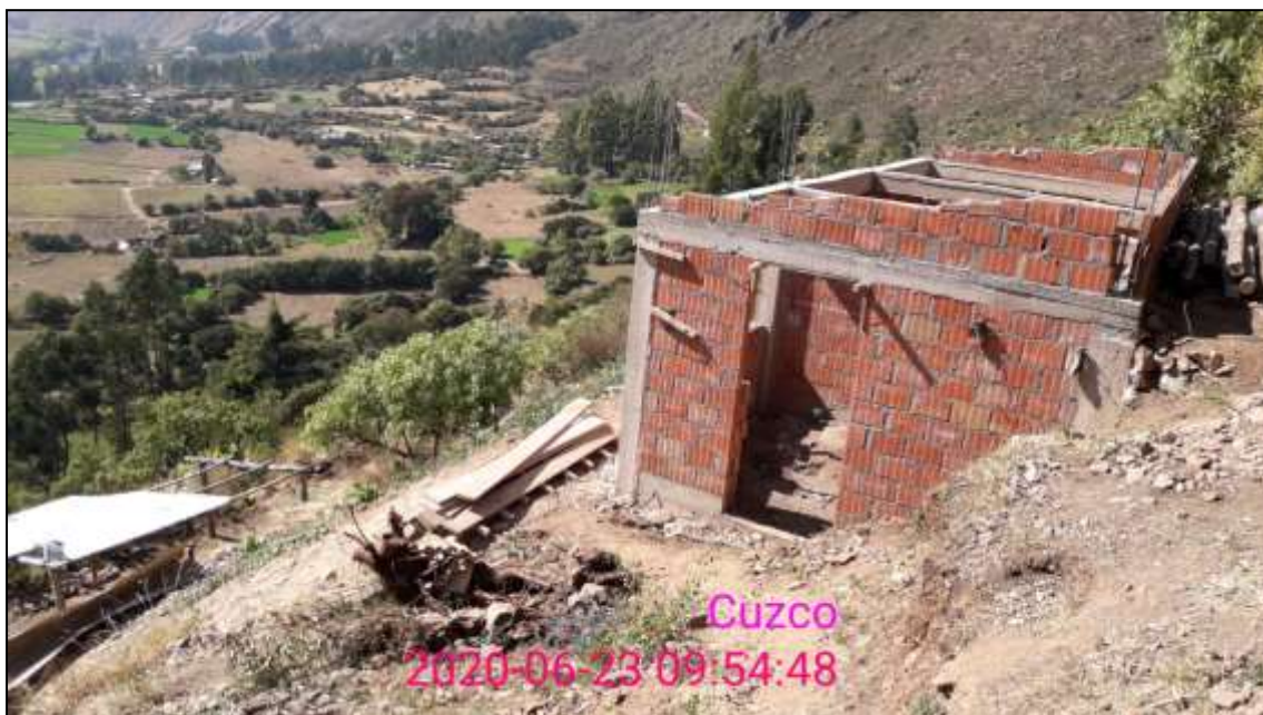
Foto N° 3 Vista de una de las construcciones con material contemporáneo que se está ejecutando en la plataforma de uno de los andenes.
