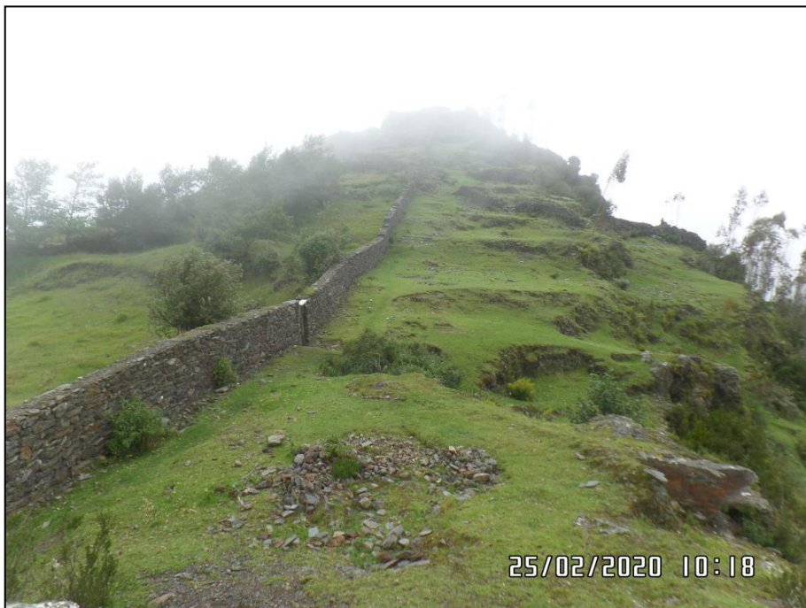
Imagen 05. Vista del muro perimetral construido en el sitio arqueológico afectando las estructuras arquitectónicas.
