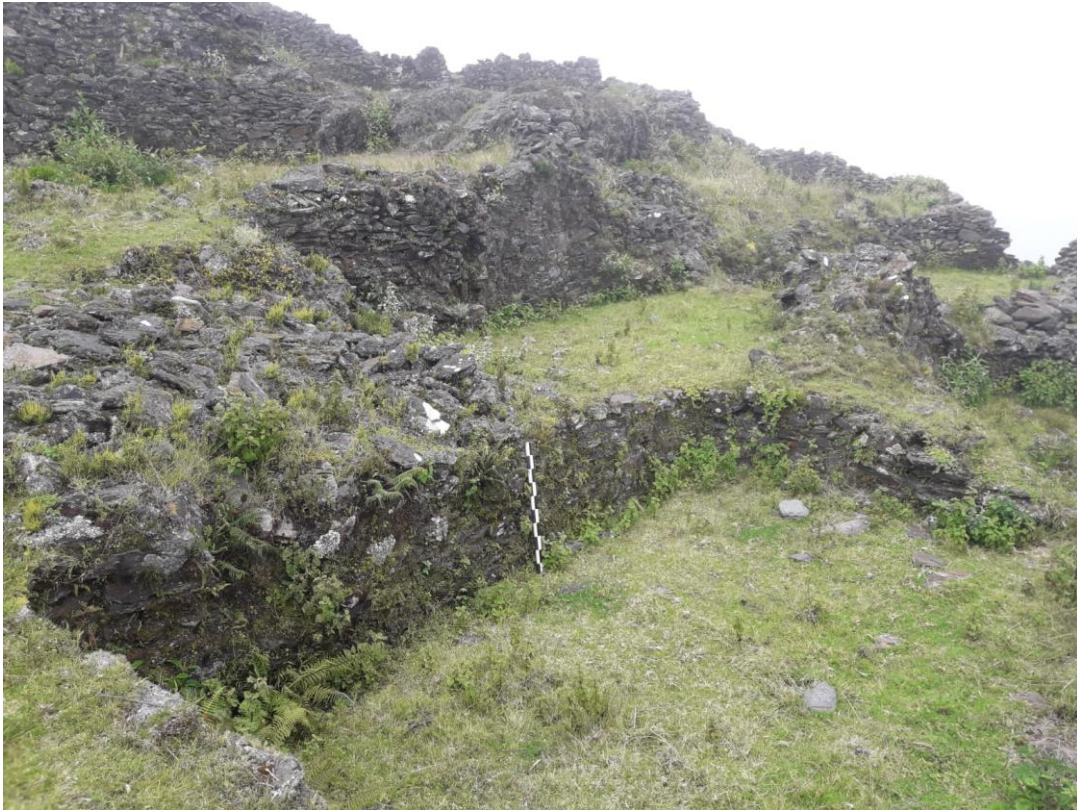
Imagen 02. Estado actual de las estructuras arquitectónicas, donde se puede apreciar el colapsamiento de los muros
