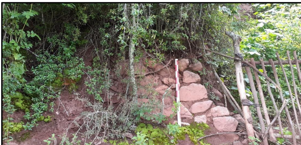
Foto N° 08: Detalle de un muro prehispánico cubierto de vegetación.
