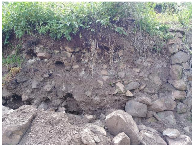
Sección de muro afectado por la apertura de acceso y la ampliación de propiedad.
