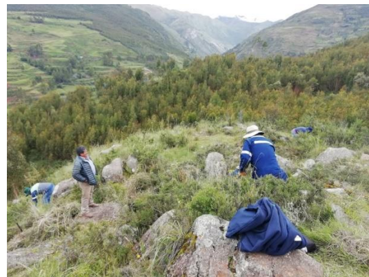
Imagen 06: véase la cantera inca donde se efectua la limpieza y retiro de arbustos.
