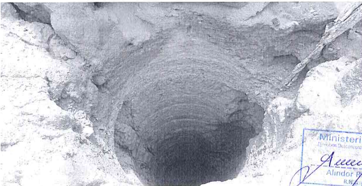
24.- Posos tubulares para extracción de agua subterránea, dentro del Sitio Arqueológico Complejo Arqueológico Metalúrgico Sicán
