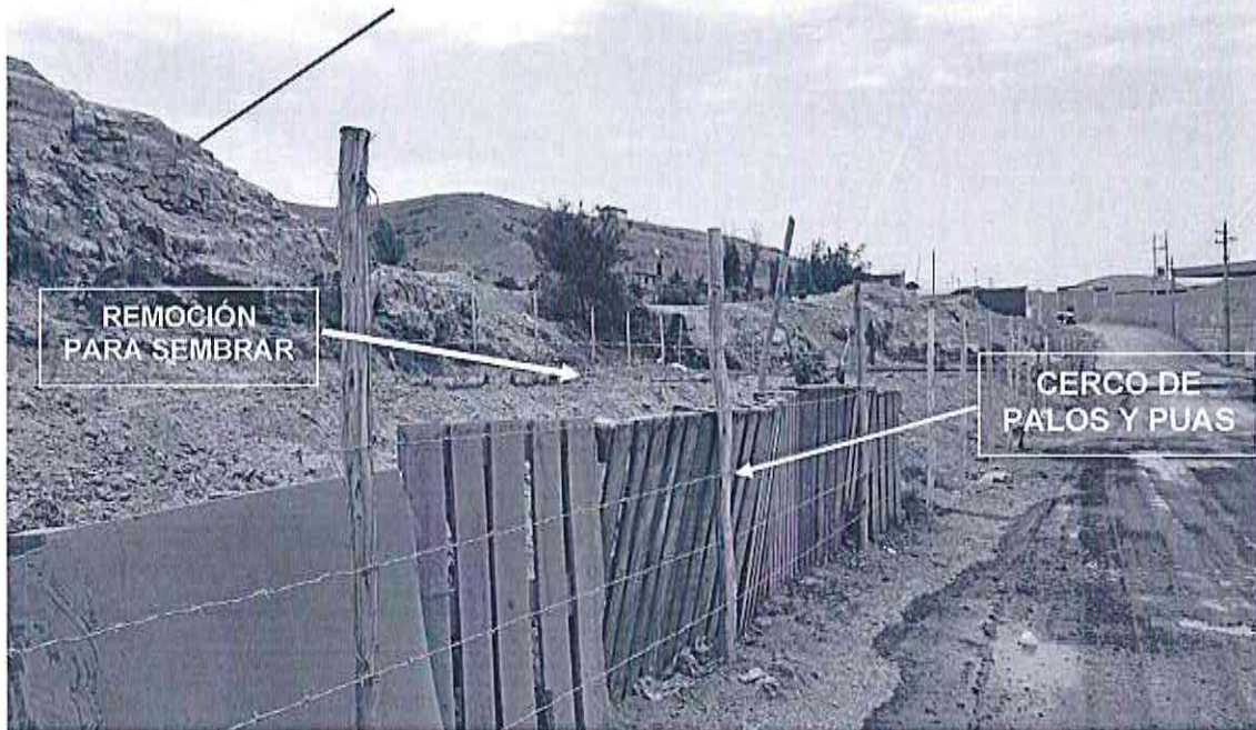
Foto 3: Paisaje Arqueológico Chuquitanta Sector 1. Vista panorámica, de la parte central (del plano del Paisaje), se aprecian trabajos de remoción de terreno con la finalidad de acondicionarlo, para sembrar plantas (en el interior del plano del Paisaje), nótese que hay plantas, el terreno está húmedo, producto del regado con agua y está cercado con palos y alambre de púas (en proceso de construir muros precarios de madera). Y están a un costado de la muralla.
