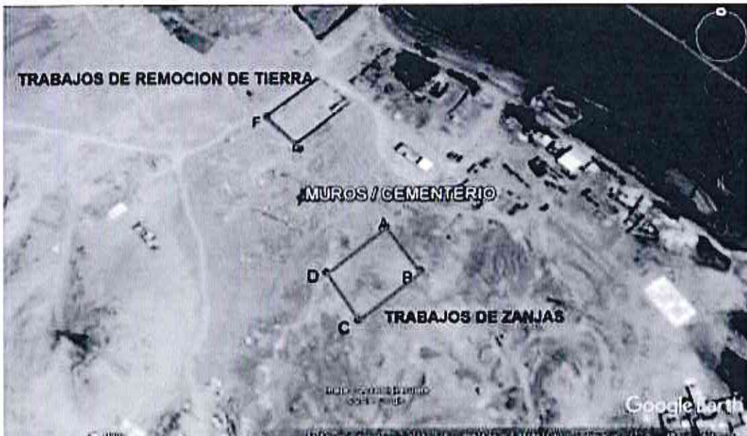
Imagen N° 6: Ubicación en Google Earth de los Puntos referenciales A,B,C, D, E y F, evidenciándose los trabajos de zanjas vaciadas con material concreto y remoción de tierra con maquinaria
