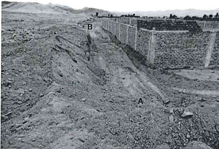
Imágenes N° 7 y 8: Trabajos de remoción de tierra en el S.A. Pampa la Capitana en Pativilca.
