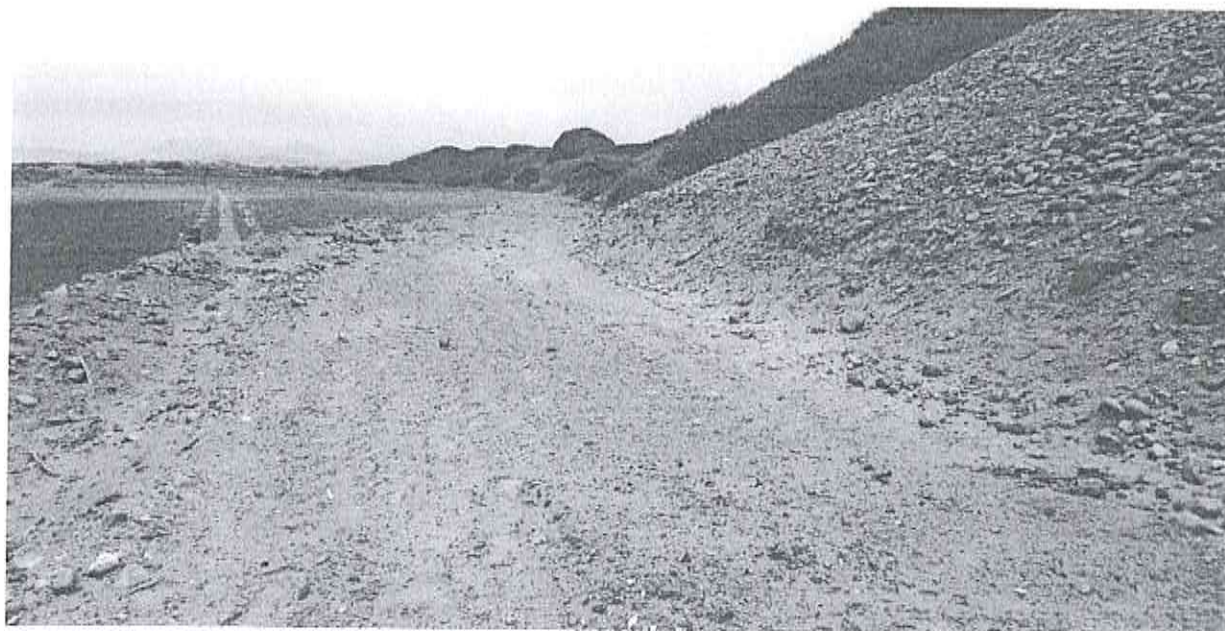
apertura de carretera dentro del área Intangible del sitio arqueológico Cerro Purulén - Murales de Ucupe
