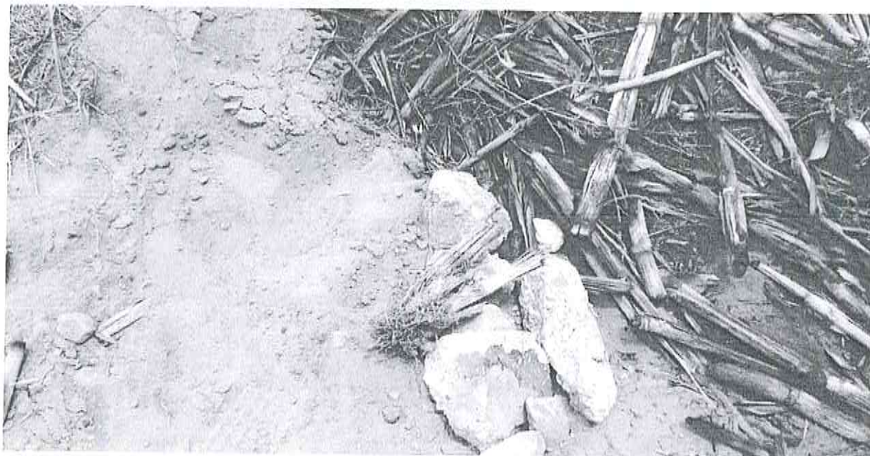
Escombros de los hitos destruidos
