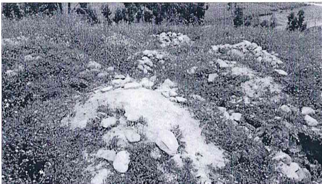
Foto N° 03: Área con zanjas para construcción de bases para muros sector "B"
