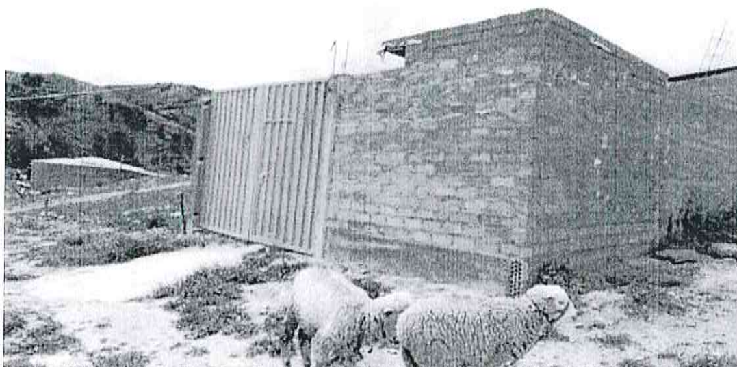
Foto N° 06: Vivienda con portón y con instalación clandestina de luz eléctrica sector "B"
