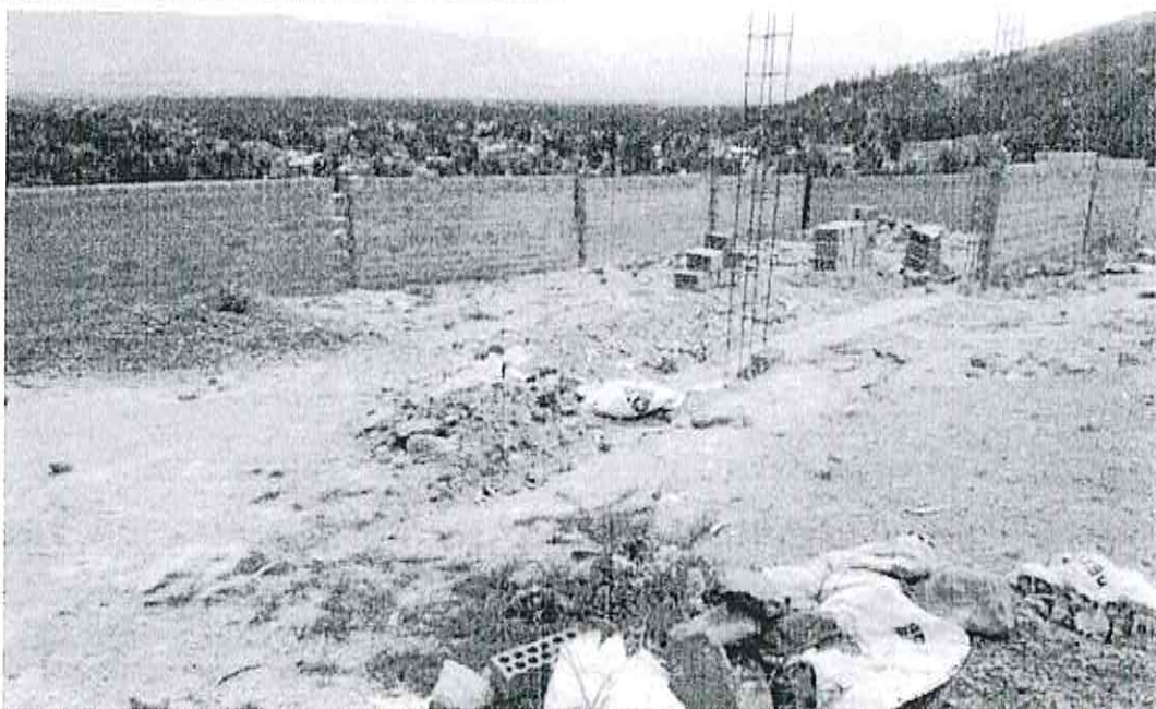
FOTO N° 01: Vivienda en construcción en la cúspide del sector "A"
