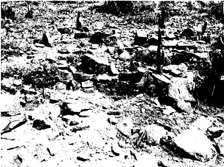
Paramento externo de muro de contención.
