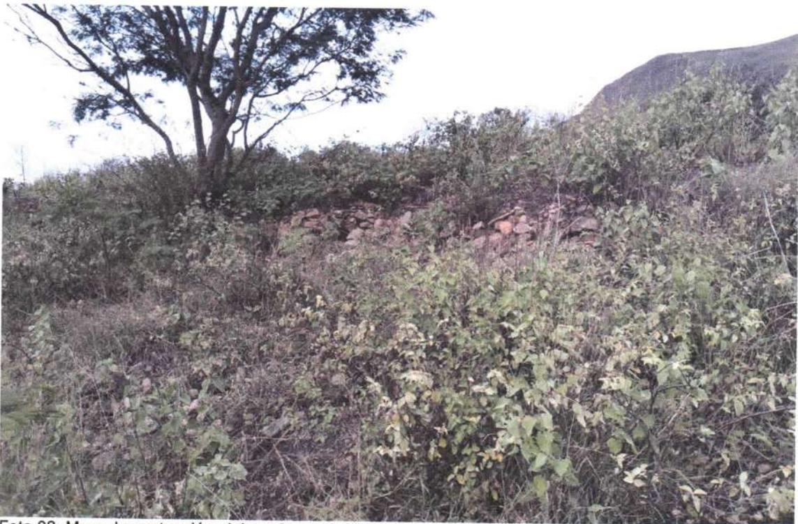
Foto 08: Muro de contención elaborado con la técnica de construcción del pircado. Ladera Oeste.
