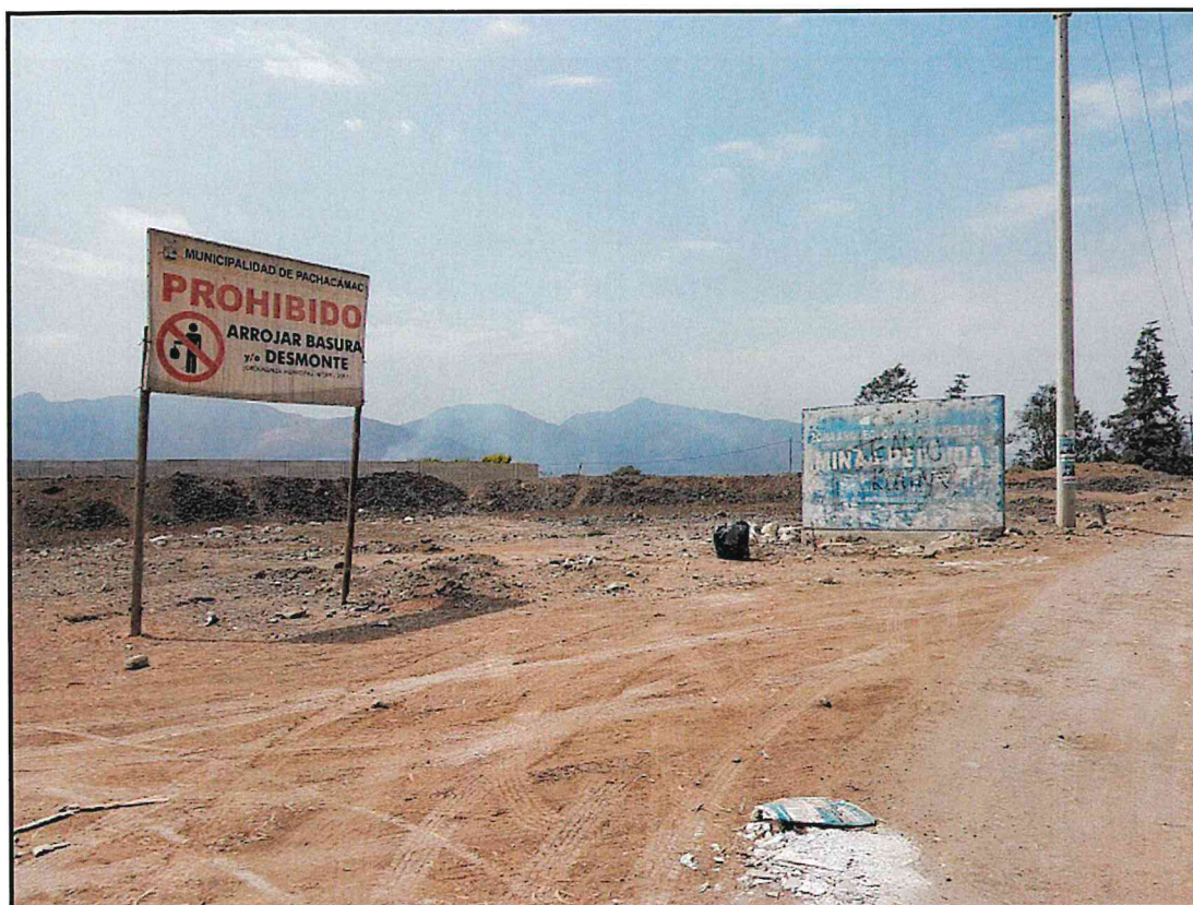
Foto 1: Zona Arqueológica Mina Perdida, Sector 2 Vista del muro de señalización en mal estado, un hito y el cartel colocado por la municipalidad de la jurisdicción.
