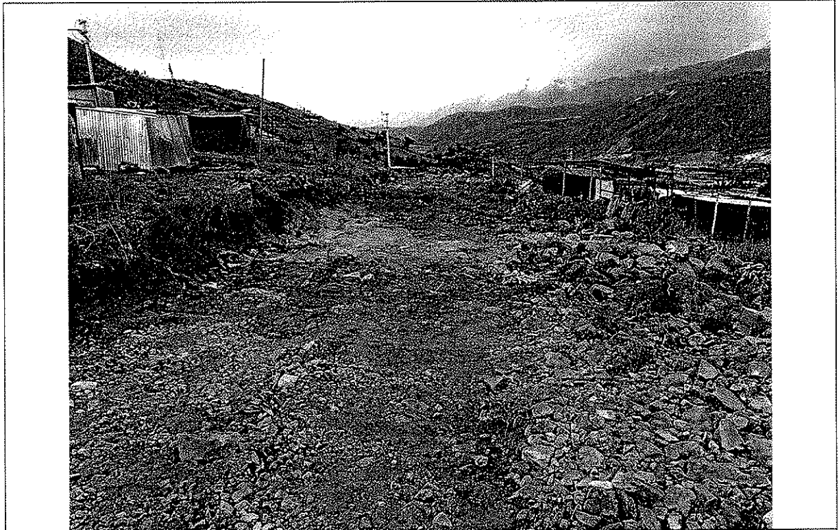
Remanente de terraza afectada por la apertura de trocha dentro del sector B.
