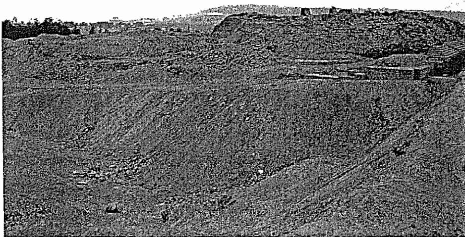
Figura 23. Desmante nivelado detrás de la Pirámide con Rampa No 1. Este desmante da el aspecto de ser una continuación de la calle Este-Oeste.
